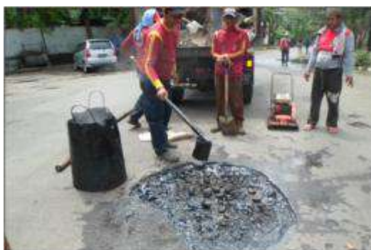
COATING BATU PECAH Merupakan proses penghamparan batu pecah 20 cm dan diberikan perekat berupa aspal cair pada jalan berlubang
