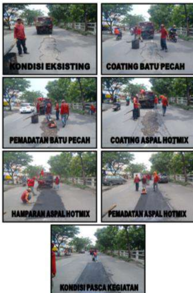
COATING BATU PECAH Merupakan proses penghamparan batu pecah 20 cm dan diberikan perekat berupa aspal cair pada jalan berlubang
